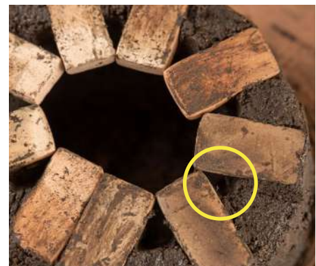
Fotos 13. Detalle de espacios necesarios entre los ladrillos del soporte de piso de horno.
