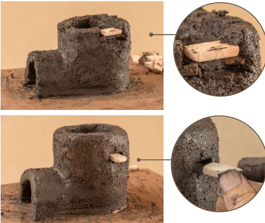
Fotos 16 y 17. Construcción de la mirilla.
