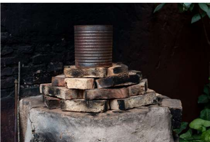
Foto 24. Chimenea del horno con ladrillos y lata.
