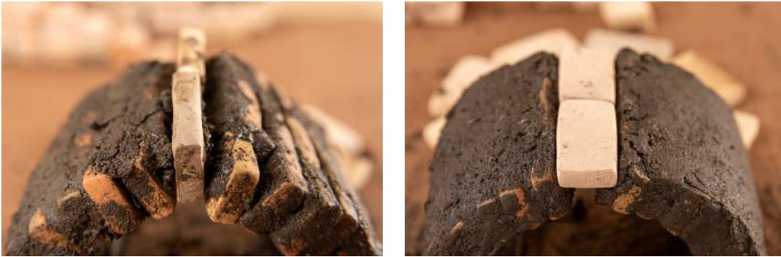
fotos 8 y 9. Construcción del arco de ingreso del fuego.
