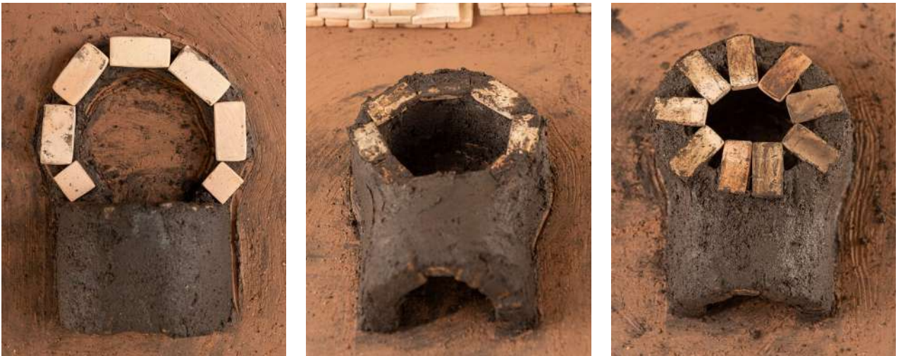
Fotos 10, 11 y 12. Construcción del arco de ingreso del fuego.
